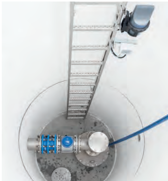
Punto de medida IP68 alimentado por batería con comunicación GSM/GPRS
