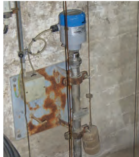
Medidor de nivel TDR como protección contra el sobrellenado en un pozo de agua
