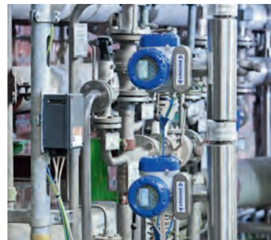
Caudalímetros Coriolis de tubo recto en una aplicación ligada a la seguridad
