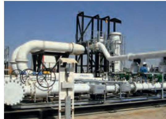
Sistema de medida montado en patín con probador bidireccional integrado
