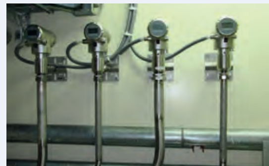
Medida de nivel TDR de condensados en entornos con radiaciones
