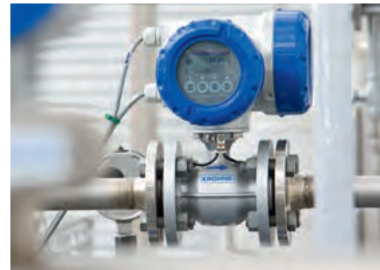
Referencia virtual para caudalímetros electro-magnéticos: los anillos de puesta a tierra ya no son necesarios
