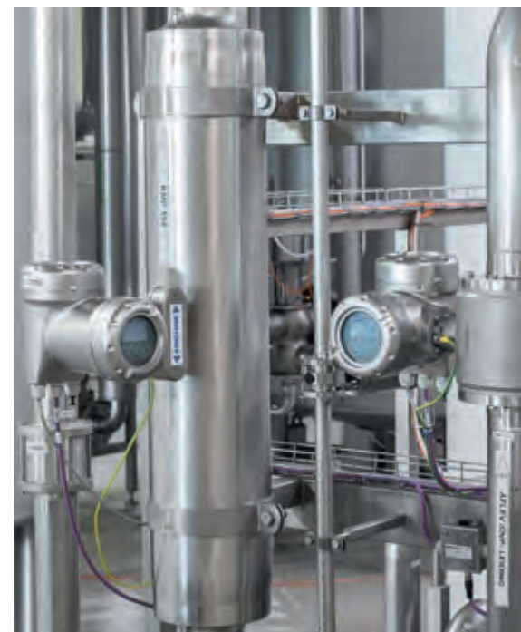
Caudalímetro másico Coriolis de tubo recto OPTIMASS para productos sensibles al esfuerzo cortante
