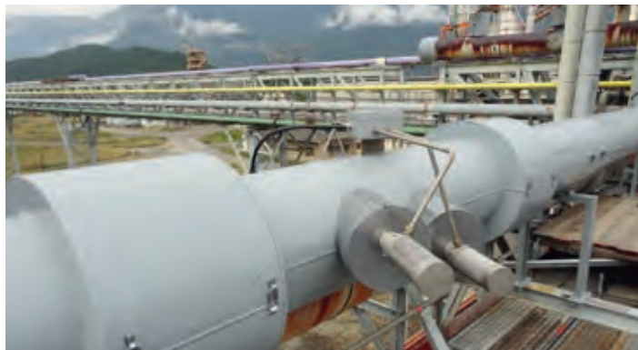
Medida de caudal ultrasónica de vapor recalentado
