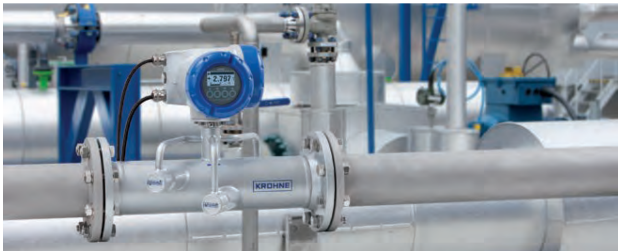
Medida de gas de proceso con el OPTISONIC 7300
